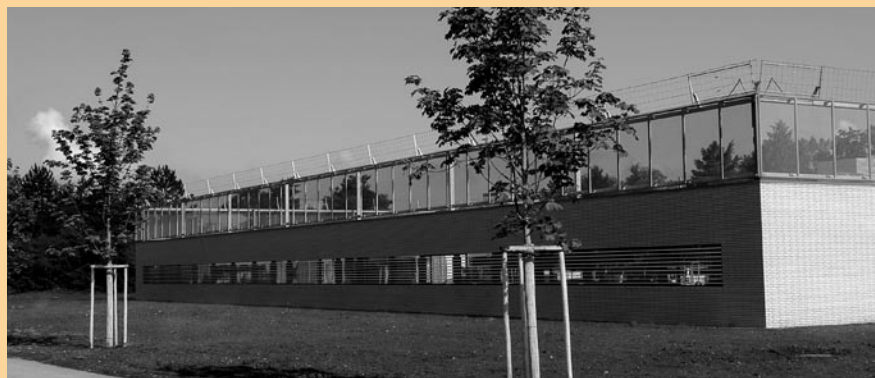
Nouvelle construction des stations de sécurité forensiques (ouverture en juillet 2007)
