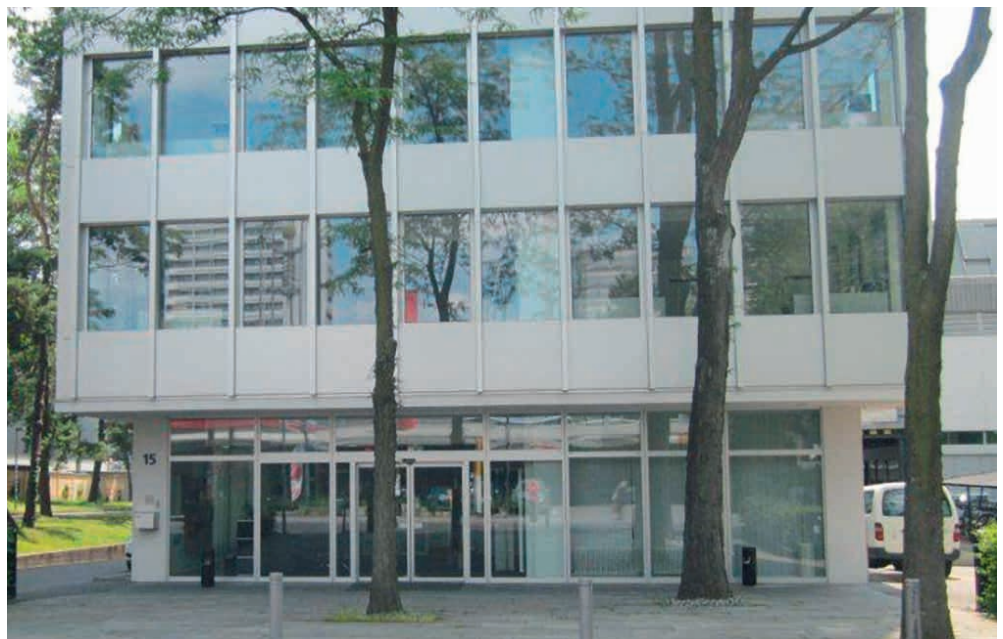
Centre névralgique : le bâtiment du CSI-DFJP à la Fellerstrasse 15 à Berne
