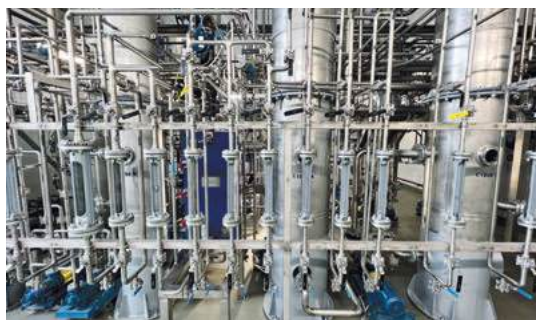
Les colonnes de distillation de la sucrerie d'Aarberg (BE) servant à produire l'éthanol suisse.
